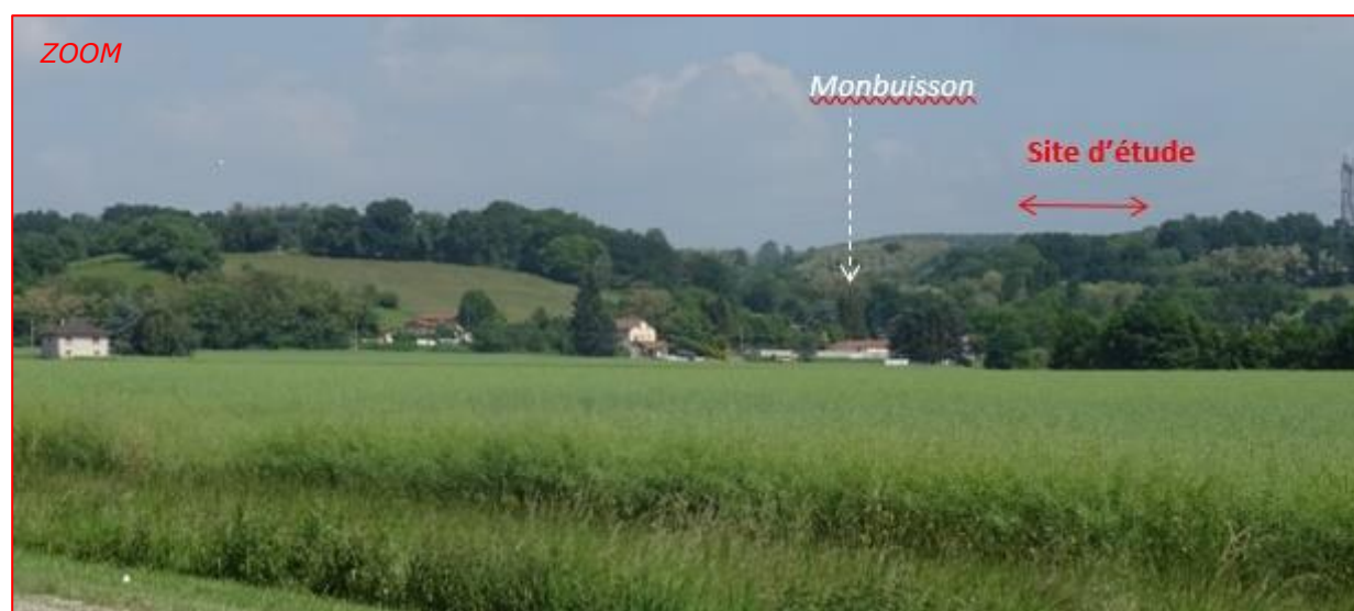
Figure 92 – Vue L depuis la RD75 en direction du site d'étude, du lieu-dit les Cabanes
